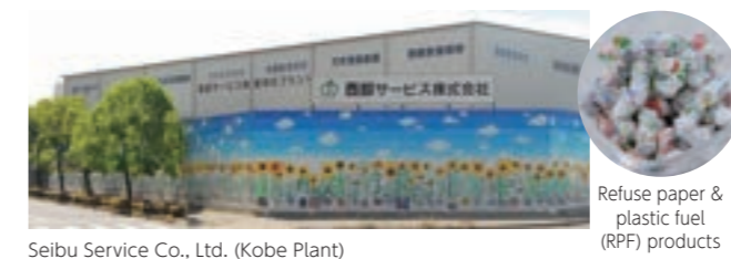
Seibu Service Co., Ltd. (Kobe Plant)
