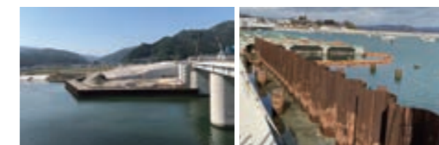
東日本大震災の被害を受けた三陸沿岸における湾岸工事現場において必要な鋼矢板を納入し、使用后、価値のあるものは中古品として再利用しました。
