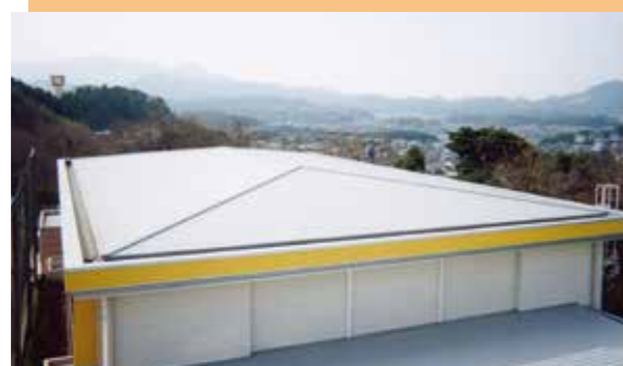
自由ヶ丘小学校校体育館(瓦棒リニューアル)
