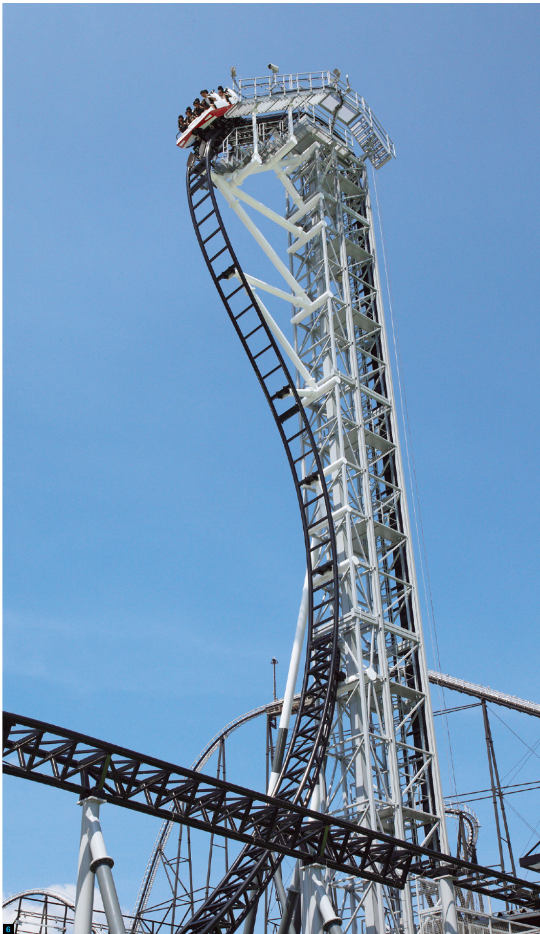
6.7.8.9.ギネス世界記録に認定された落下角度121°の「パーティカルドロップ」。垂直巻上げ方式で高さ約43mの最高部まで引き上げ、一旦停止後、えぐるような角度で一気に加速する絶叫体験はまさに高飛車のハイライトだ 10.軽快なアクションを可能にする8人乗り単車両 11.リニアランチ方式によりトンネル内から約2秒で時速100kmまで加速する
